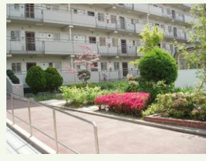
3号棟北側から西側
