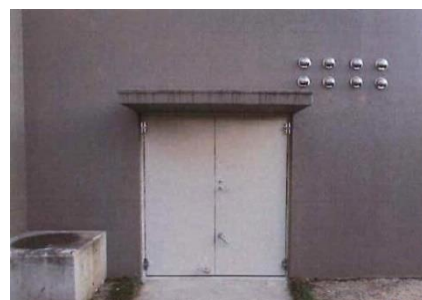
各棟電気室に防水扉を設置
