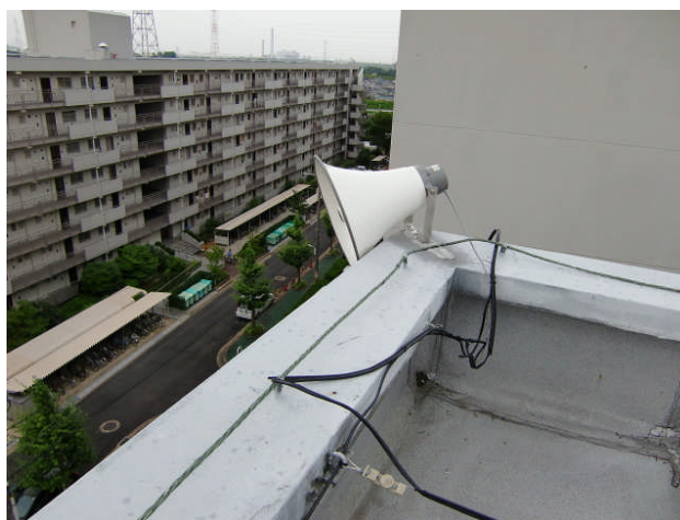
3号棟 屋上西南角
