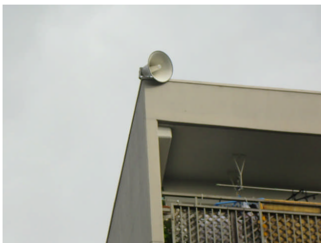
1号棟 屋上西南角
