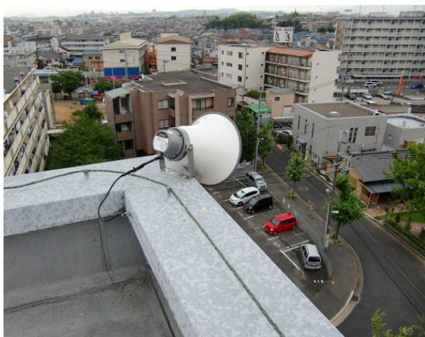
3号棟 屋上東南角 (新設)
