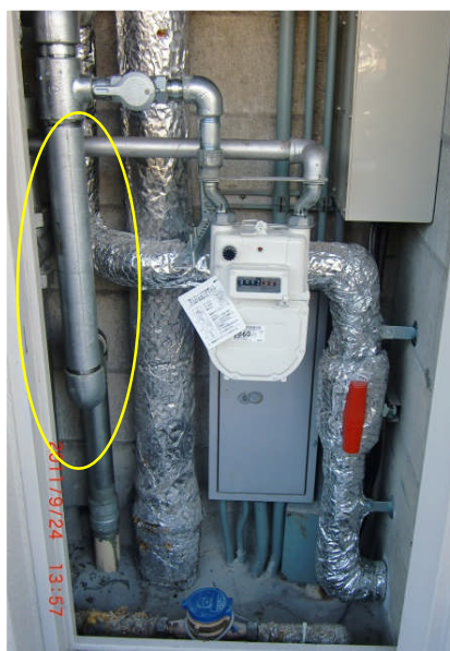
1階PS内縦管接続・メーター装着
