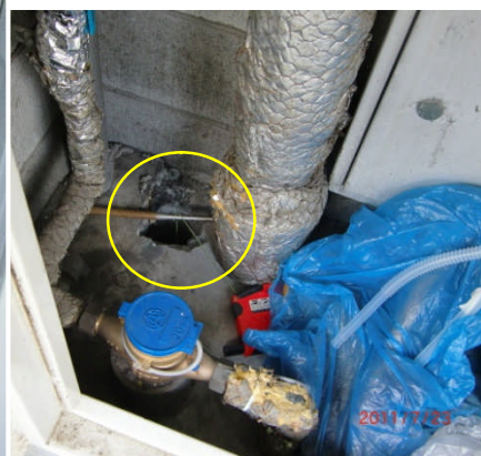
ピットよりPS内への引込み穴
