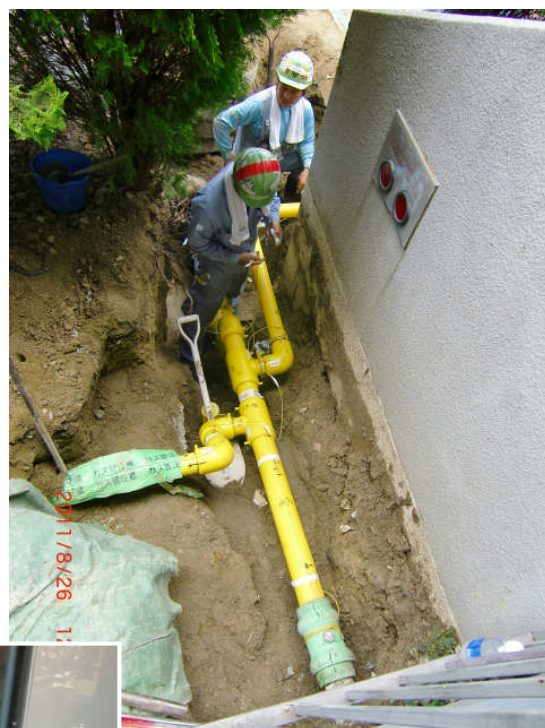
埋設新管更新作業
