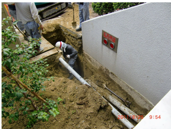
旧埋設管撤去作業
